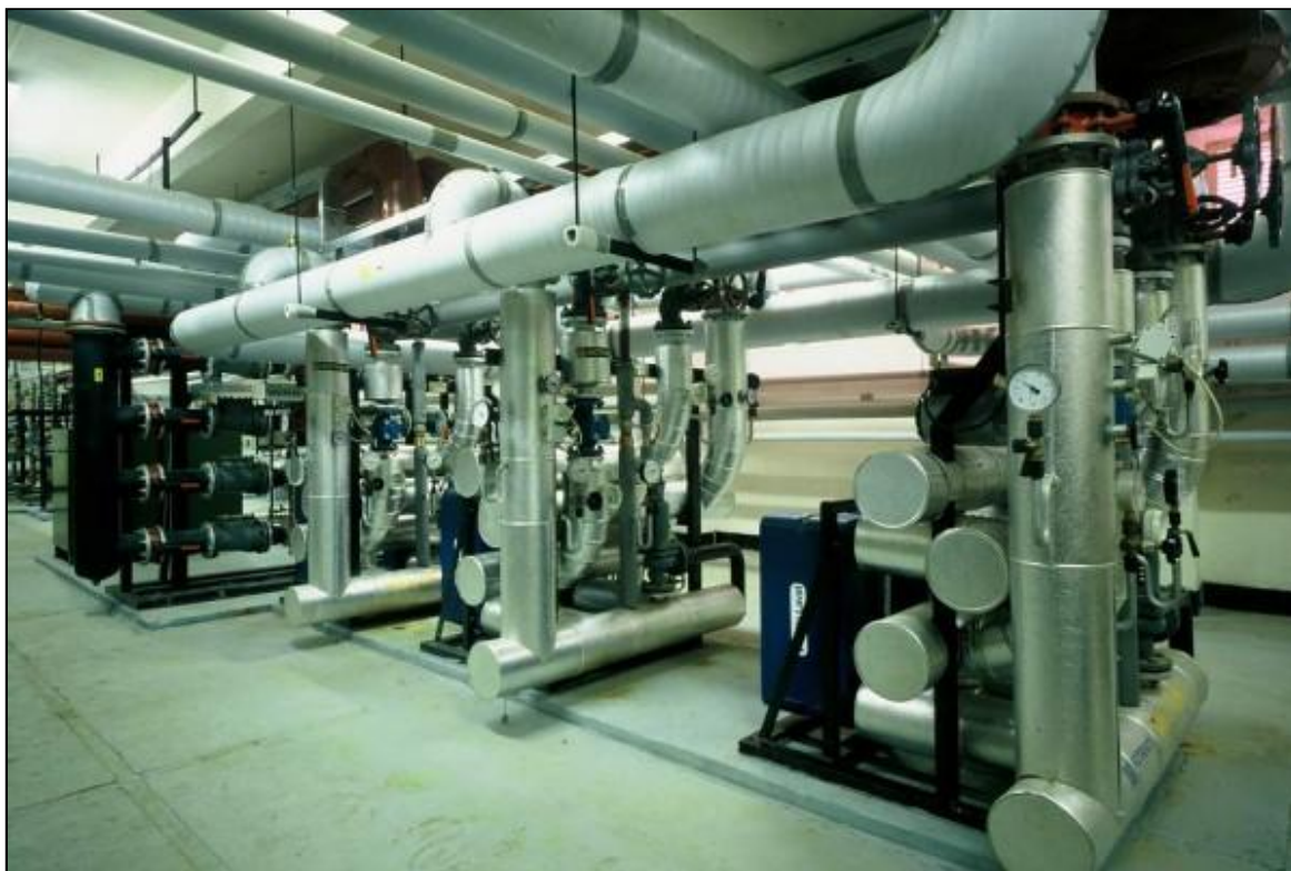
Obr. 1 Bloková výměníková stanice voda - voda
