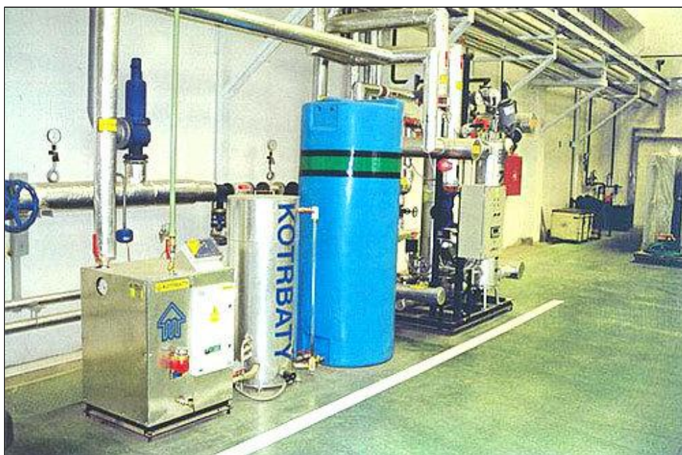
Obr. 7 Expanzní zařízení s doplňováním ve výměňkové stanici
