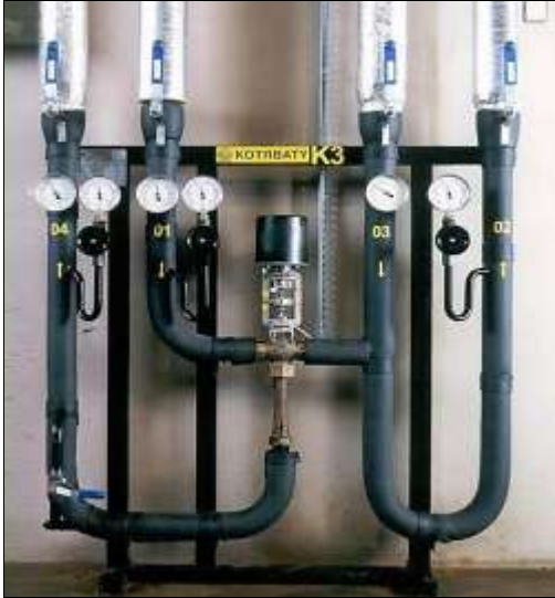
Obr. č. 2 - Ejektorový blok
