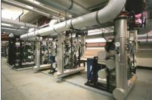
Obr. č. 1 - Stavebnicová výměňková stanice voda-voda s deskovými výměníky
