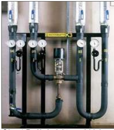
Obr. 4 Reálný ejektorový blok
