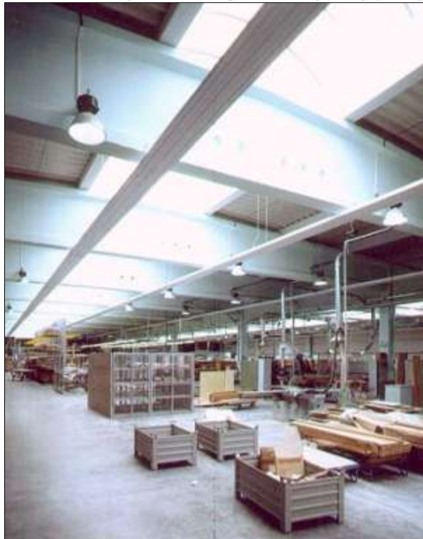
Vytápění výrobní haly zavěšenými sálavými panely
